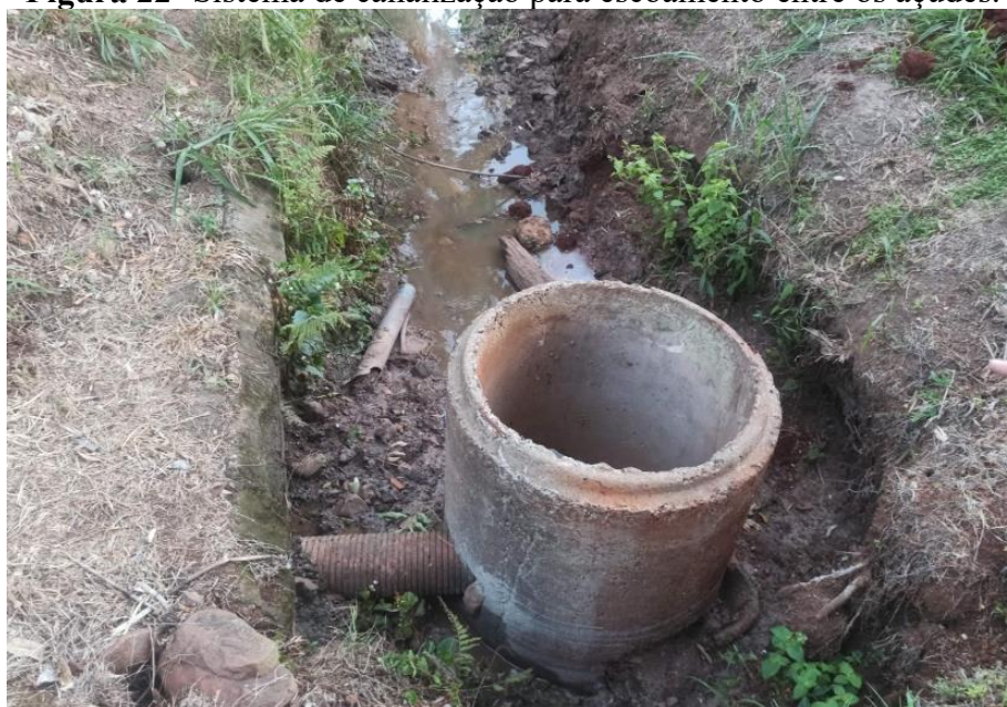
Figura 22- Sistema de canalização para escoamento entre os açudes.
